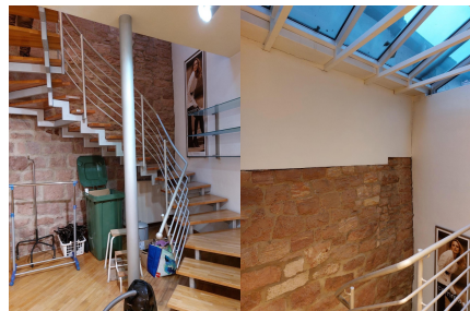
Alte Stadtmauer als Häusertrennwand in einem kleinen Ladengeschäft in der Bahnhofstraße (Abgrenzung zu den Häusern der Hallgasse). Die schräg verlaufenden Häuserrückwände und Zwischenwände zwischen Bahnhofstraße und Hallgasse lassen auf viele weitere erhaltene Stadtmauerabschnitte innerhalb der Häuser schließen (Fotos privat).
