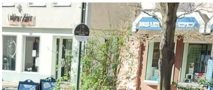
Alte Stadtmauer als Hausrück- bzw. Trennwand am Lindenplatz (Foto privat).
