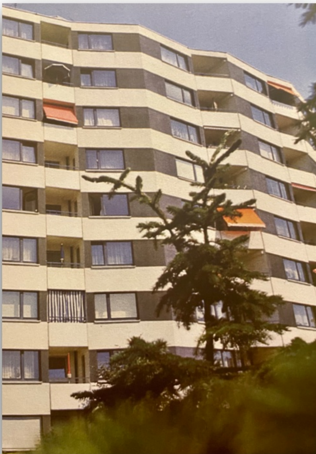
Abb. 85: Neungeschossiges Wohnhaus an der Rheinlandstraße ist im „gefalteten Grundriss“ erbaut (bietet ebenfalls die Gewähr, dass kein Nachbar dem anderen ins Fenster schauen kann)
