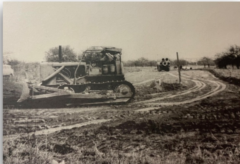
Abb. 24: Tiefbauarbeiten (Verlegung von Leitungen: Wasser, Strom, Gas)
