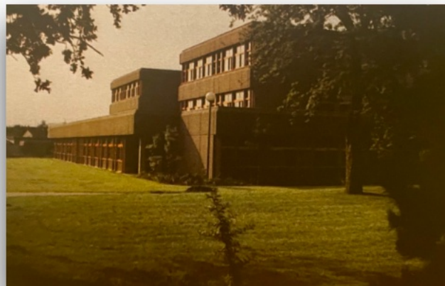
Abb. 66: Gebäude für Gymnasiale Oberstufe
