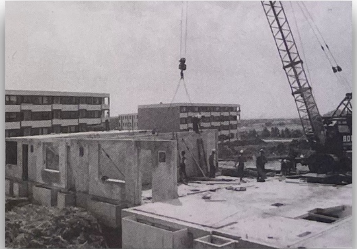
Abb. 27: Montage Erdgeschoss des Reihenhauses
