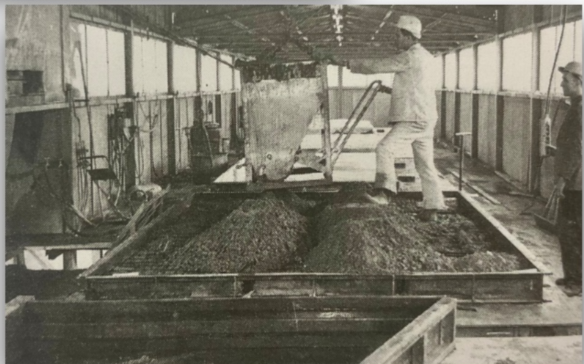
Abb. 51: Die Innenansicht der Feldfabrik
