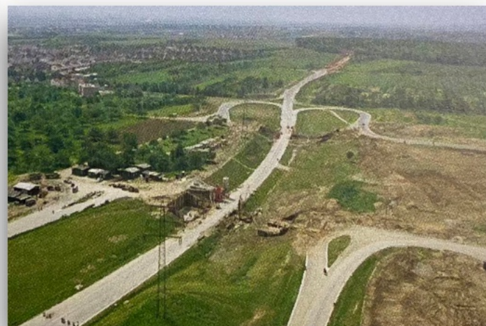
Abb. 43: Limesspange im Bau
