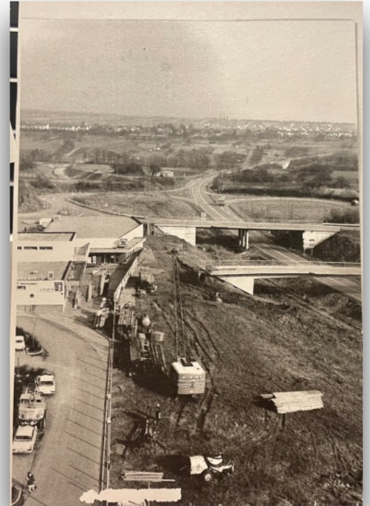
Abb. 41: Bauarbeiten am Hang zur Limesspange, sowie der S-Bahn Trasse und drei Brücken nach Altschwalbach (heute Überdachung)
