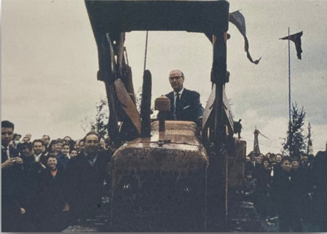
Abb. 19: Baubeginn und 1. Spatenstich (hessischer Innenminister Dr. Georg August Zinn auf dem Räumbagger)
