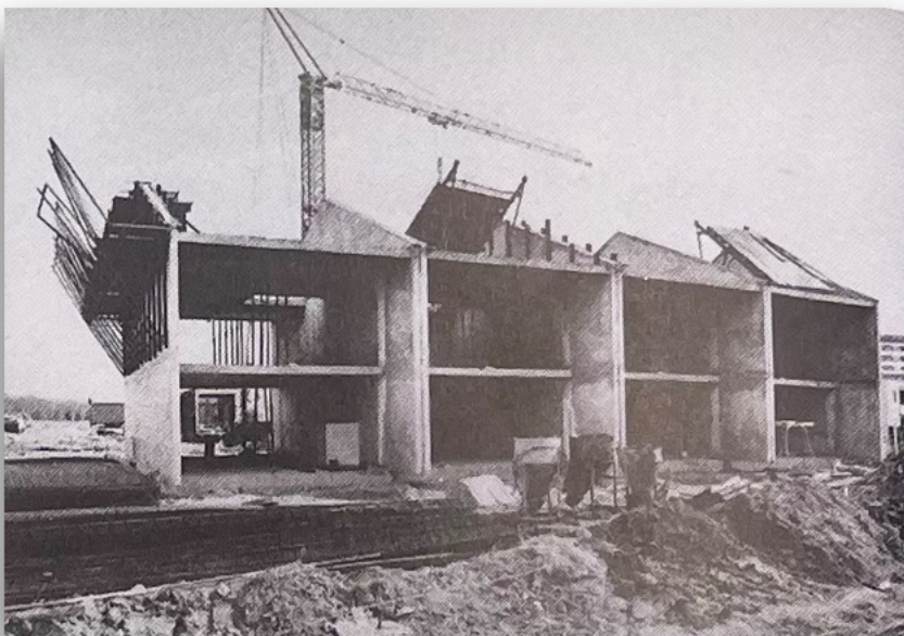
Abb. 28: Montage in der Wohnstadt Limes
