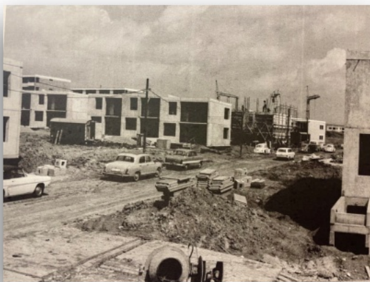
Abb. 25: Reihen- und Einfamilienhäuser aus Fertigteilen
