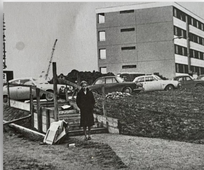
Abb. 49: Wohnen auf der Baustelle
